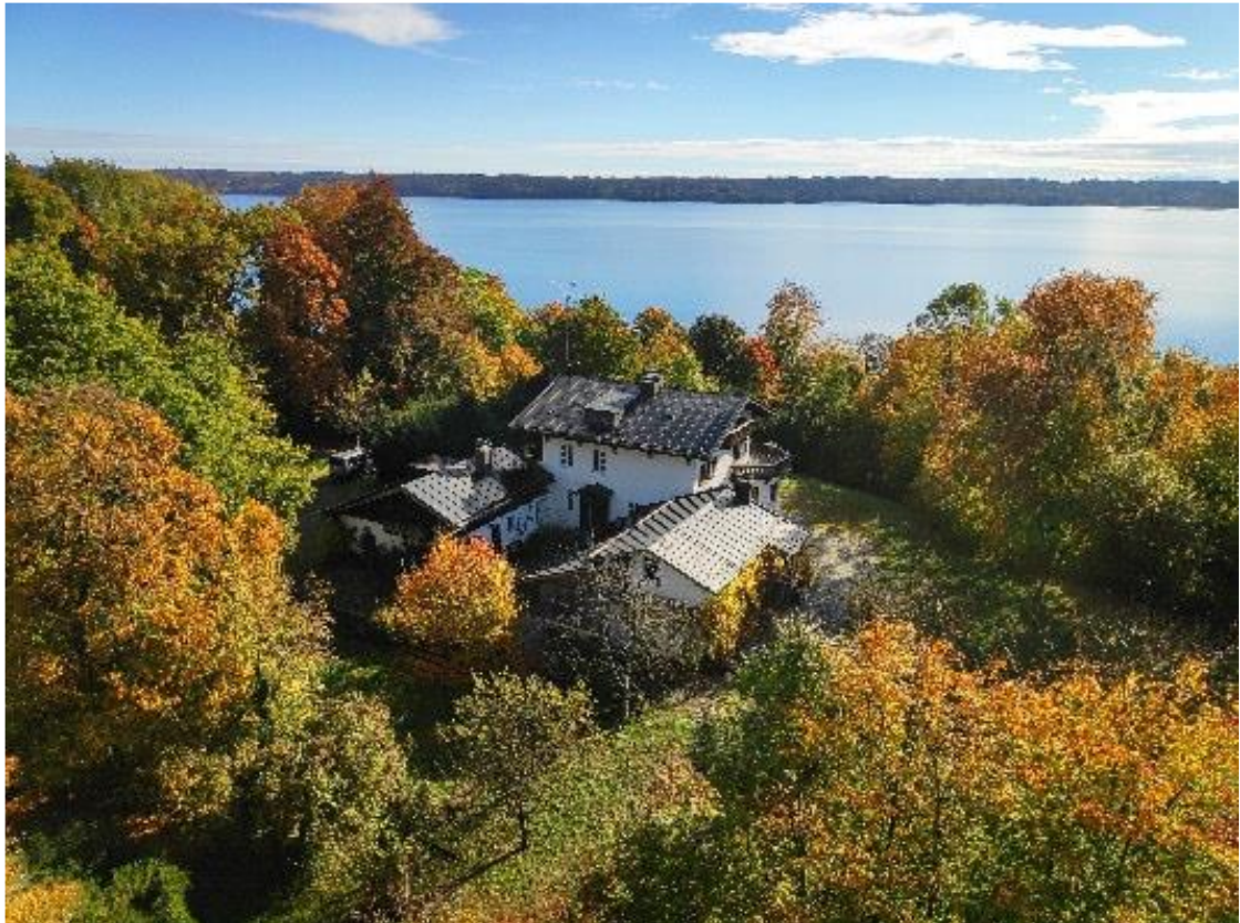
Abb. 9: Villa mit Nebengebäuden im Herbst 2022, Blick nach Osten. Die Aufnahme zeigt, in welchem Umfang sich die Gehölzbestände vor allem auf der Seeseite ausgeweitet haben. Die überschüttete Fläche des ehemaligen Rosengartens wurde auf eine kleinflächige Wiesenböschung reduziert, die anlageprägenden Blickbeziehungen zum See sind gänzlich verschwunden
